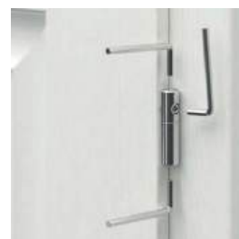
regulacja zawiasów czopowych regulowanych 3D
