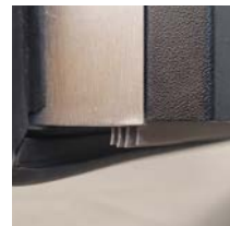
uszczelka wargowa, przyłga z uszczelką
